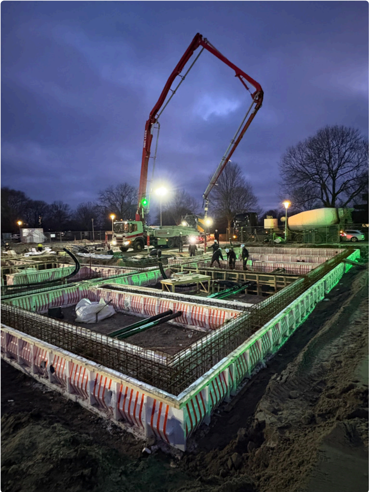
Storten circulair beton in Heechterp
