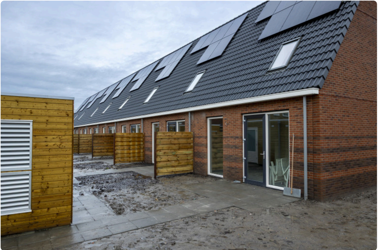
Nieuwbouw Jogchum Nieuwenhuisstrjitte Grou 14 woningen
